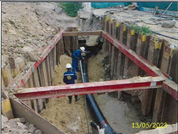
การติดตั้ง Sheet Pile ในพื้นที่ที่มีความเสี่ยงด้านดินถล่ม
