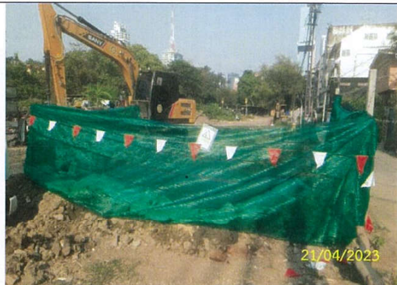
ก) การวางถุงทราย/จัดทำคันดินโดยรอบบ่อรับบ่อ-บ่อส่งป้องกันการปนเปื้อนของโคลนโซเดียมเบนโทไนท์
