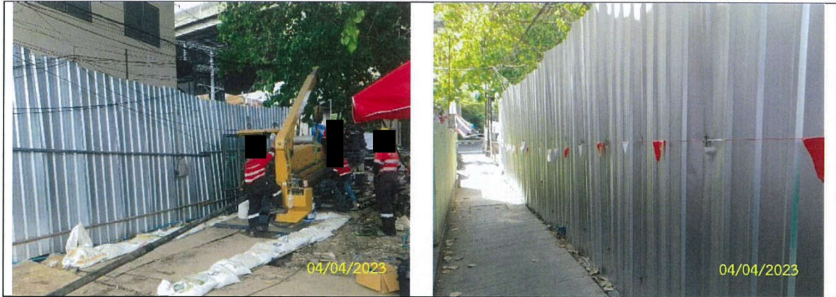
รูปที่ 2-10 การติดตั้งกำแพงกันเสียงชั่วคราวบริเวณพื้นที่บ่อส่ง
