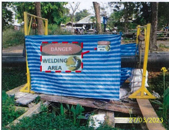
ค) การกั้นเขตบริเวณที่มีการเชื่อมและติดตั้งป้ายเตือนห้ามผู้ที่ไม่เกี่ยวข้องเข้ามาในพื้นที่ปฏิบัติงาน
