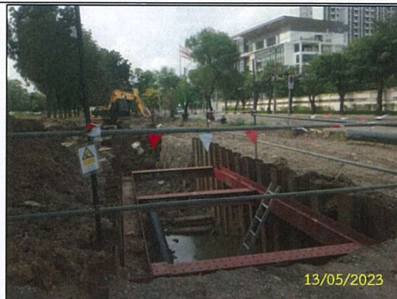
การติดตั้ง Sheet Pile ในพื้นที่ที่มีความเสี่ยงด้านดินถล่ม
