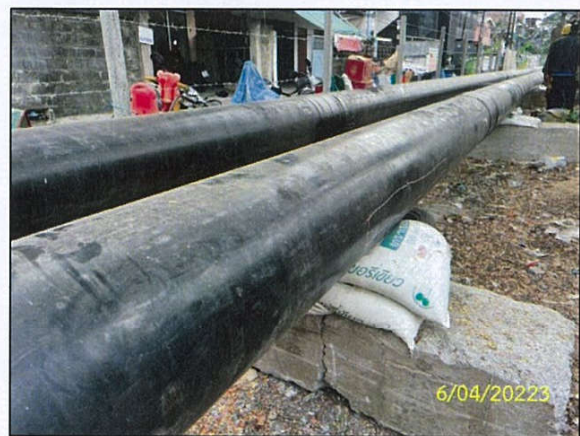
ข) การจัดวางท่อนส่งน้ำมันบนวัสดุรองรับ
