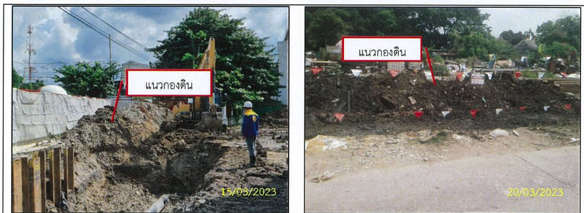
รูปที่ 2-18 จัดวางกองดินให้ห่างจากแหล่งน้ำ อย่างน้อย 15 เมตร
