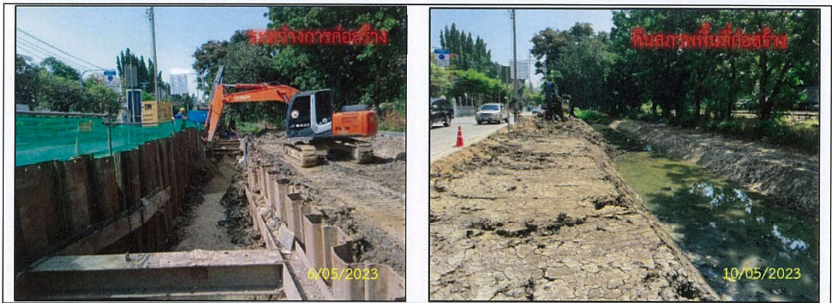
รูปที่ 2-4 การเปิดหน้าดินเป็นช่วงสั้นๆ เพียงพอสำหรับการก่อสร้างและเร่งดำเนินการฝังกลบเมื่อดำเนินงานแล้วเสร็จ
