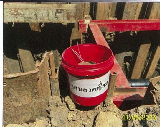
ง) ภาพสำหรับจัดเก็บเศษโลหะป้องกันประกายไฟไปสัมผัสกับวัสดุติดไฟ รูปที่ 2-29 (ต่อ) การปฏิบัติตามมาตรการฯ ในกิจกรรมการเชื่อม
