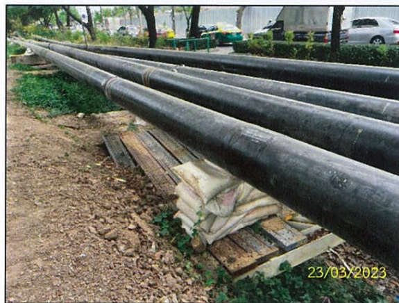
ข) การจัดวางท่อนส่งน้ำมันบนวัสดุรองรับ
